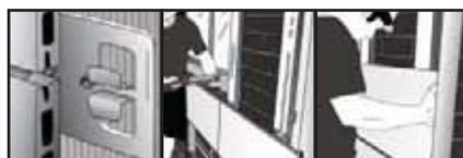
Sistema mixto de anclaje mecánico y adhesivo que garantiza el reparto de tensiones, evita rotura de las piezas y garantiza su durabilidad
